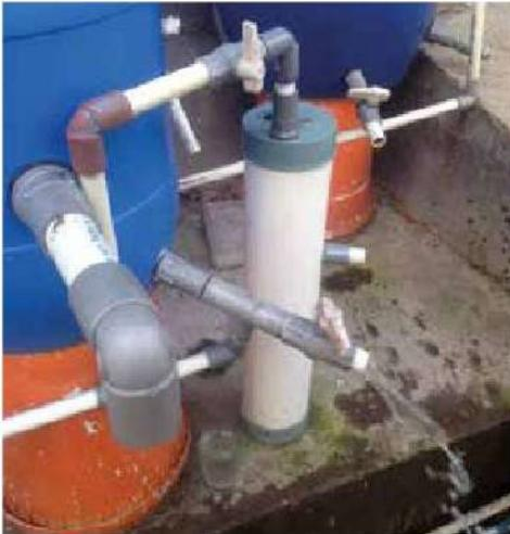
Gambar 3. Proses Klorinasi dan Keran Air Bersih hasil dari WTP Mini Generasi 1 (sumber : dokumentasi Bapelkes Cikarang 2018)
